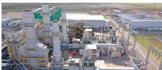
(3) Usina Termelétrica Jaguatirica II - Boa Vista/RR
