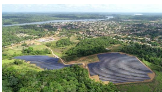
(2) Sistema híbrido, composta de usina fotovoltaica usina térmica - Oiapoque/AP
